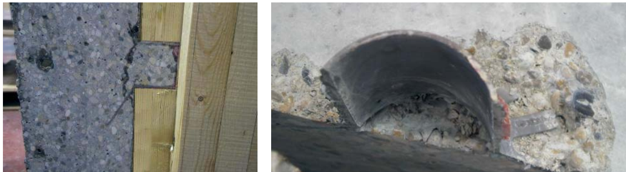
Figure III-8 Mode de rupture pour le spécimen sans fond de coffrage.
